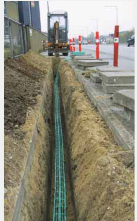
Udlægning af advarselsnet ved håndkraft
